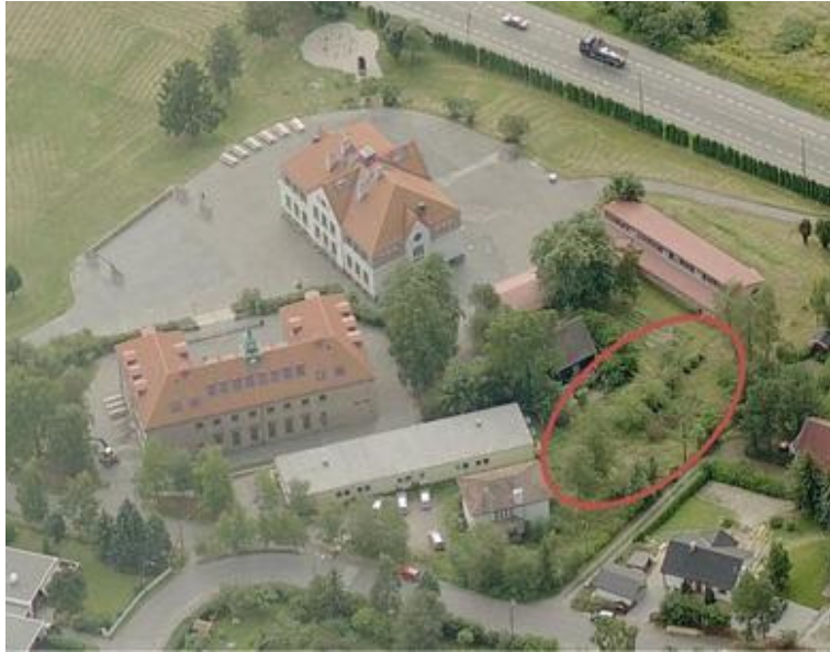
Bilde 4 -Oversiktsbilde av Østensjø skole. Den røde ringen illustrerer hvor kroppsøvingssalen / passivhuset skal ligge Kilde: Undervisningsbygg, Oslo Kommune
